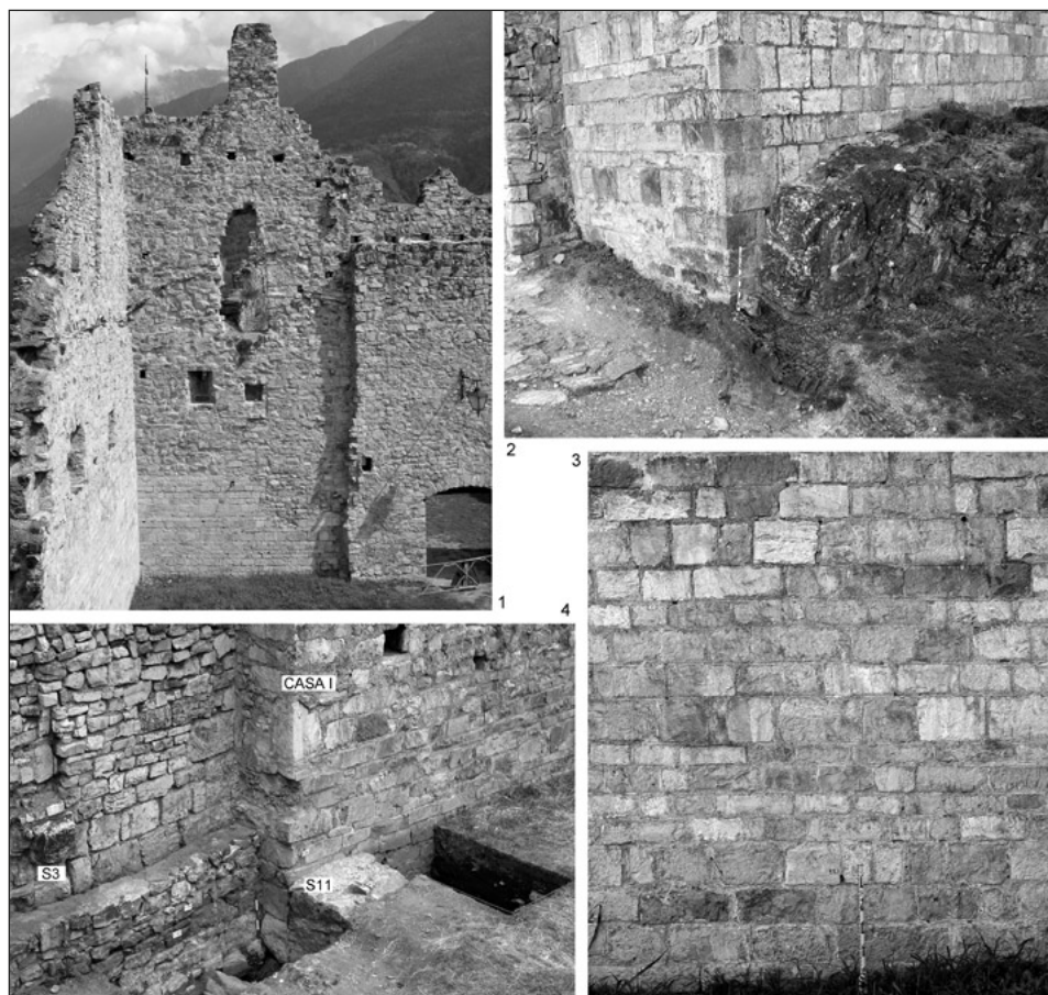
fig. 6 – Muri di case in “opera quadrata” liscia con giunti di malta ‘stilati’ inglobati nella cinta fortificata tardomedievale: 1 = Casa H, spigolo interno Nord-Est; 2 = Casa H, spigolo esterno Nord-Est, fondato su roccia; 3 = Casa H, particolare del lato interno Nord; 4 = Casa I, spigolo esterno Sud-Est, a cui si appoggiano varie strutture successive, tra cui la testata Ovest del muro S11; a sinistra, adentellati e morse superstiti del muro S3 (Casa S).
