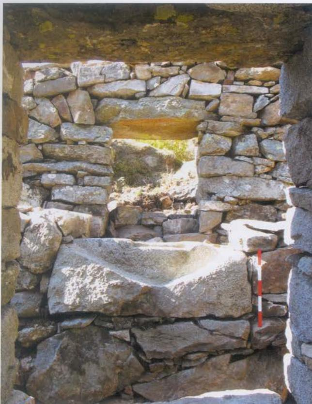
Fig. 9. Opificio in riva destra Sessera: supporto lapideo sagomato (I2) dell'albero della ruota idraulica (graduazione scala: 10 cm).
