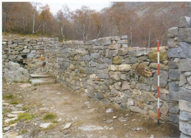
Fig. 16. Opificio in riva destra Sessera: settore Nord-Est del vano L, restauro ricostruttivo di murature della I e della II fase metallurgica e scalinata interna L7 (graduazione paline: 20 cm).
