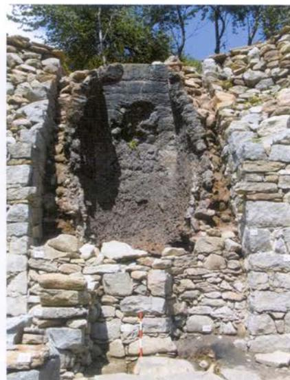
Fig. 4. Particolare del camino dell'alto forno dopo i restauri ricostruttivi (graduazione scala: 10 cm).
