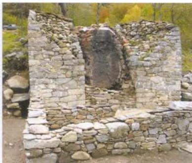
Fig. 3. L'alto forno e l'edificio pastorale antistante dopo i restauri ricostruttivi.
