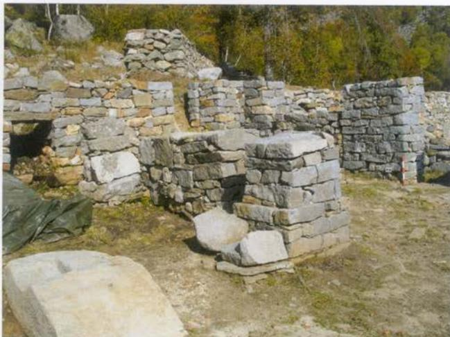
Fig. 11. Opificio in riva destra Sessera: settore centrale del vano F dopo il restauro ricostruttivo, con in primo piano il supporto lapideo sagomato (F10) dell'albero della ruota idraulica e sullo sfondo la rampa R (graduazione scala: 10 cm).
