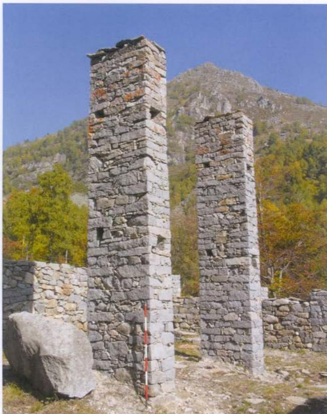
Fig. 13. Opificio in riva destra Sessera: pilastri assiali L2 e L1, da Sud, dopo il restauro ricostruttivo (graduazione palina: 20 cm).
