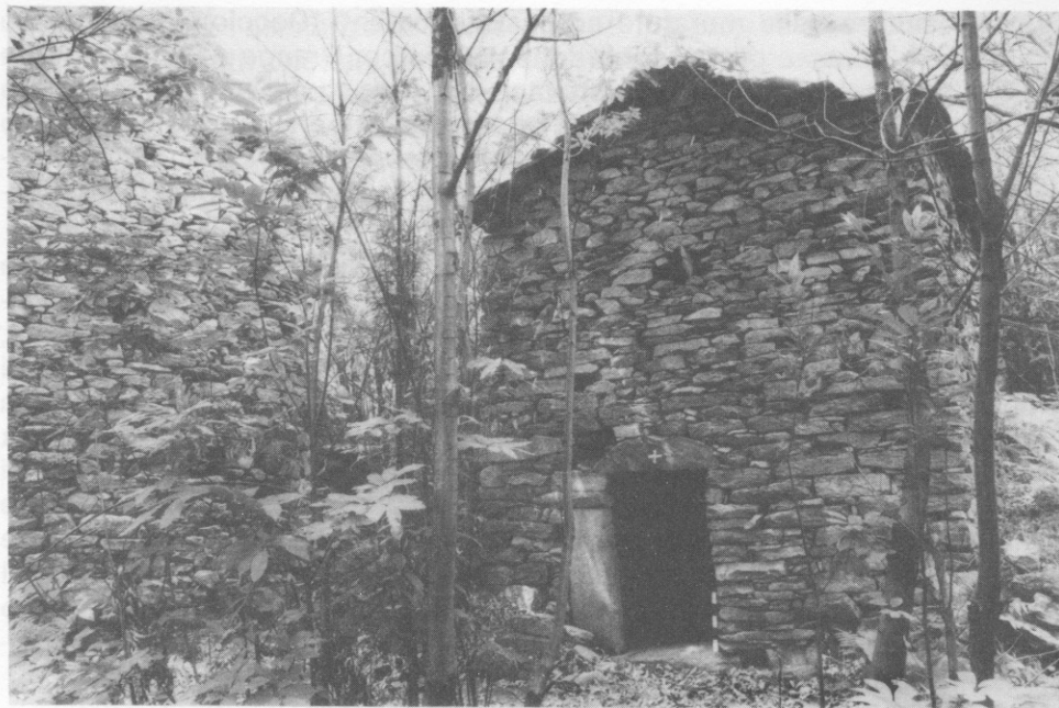
Edificio rurale di Uvera: piedritto e architrave crocesegnato (OS 120) reimpiegati in una costruzione di modesto impegno (1979).
